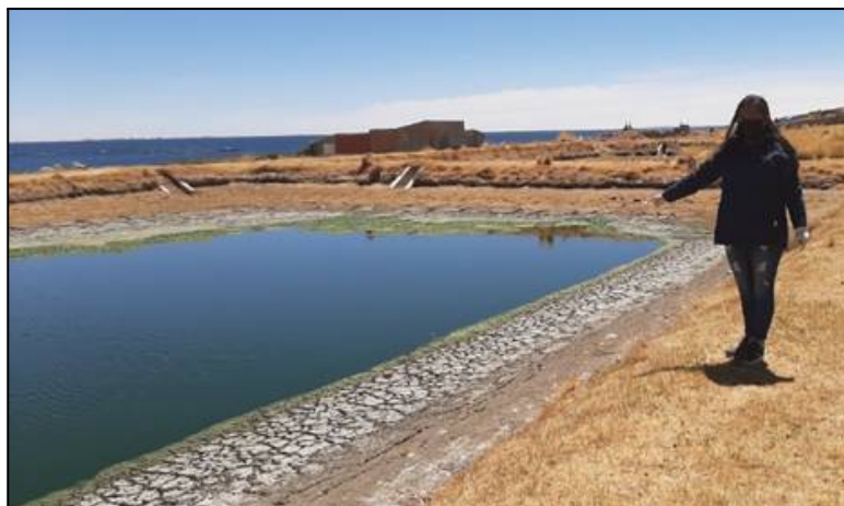
Figura 07: Diagnóstico de la segunda laguna de oxidación
