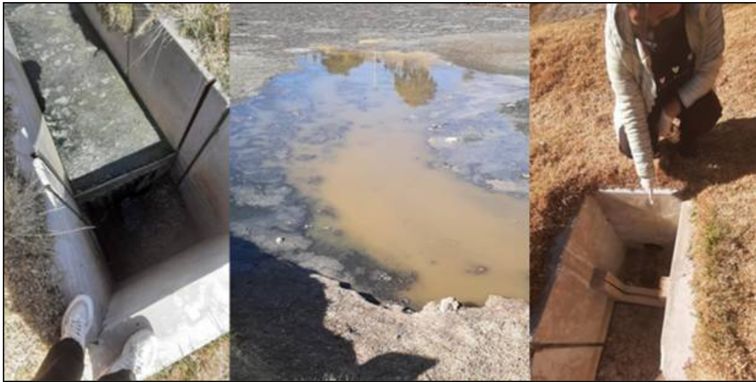
Figura 05: Verificación del ingreso y exteriores de la laguna
