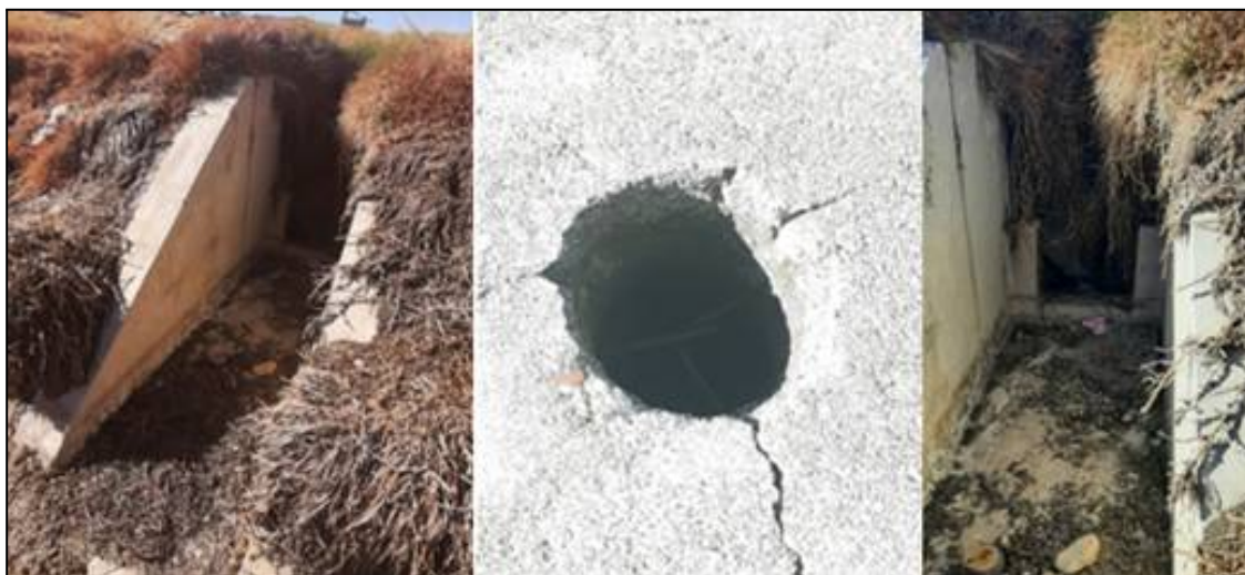
Figura 04: Estado actual de los componentes de las lagunas
