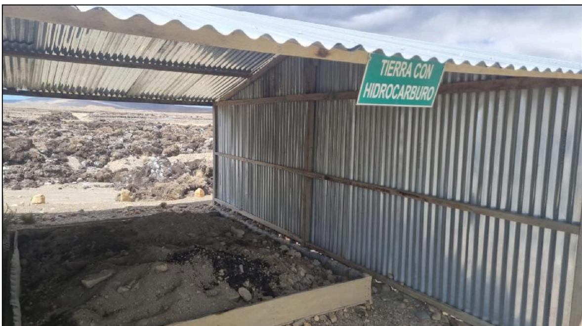
**Figura 13:** Área de volatilización de tierra contaminada.
