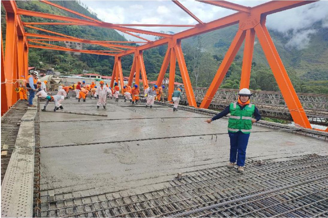
Figura 05: Colocado de concreto en la subestructura Tablero
