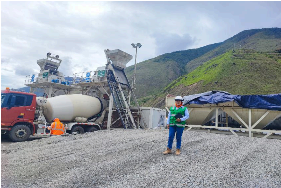
Figura 07: Producción de concreto premezclado para puente Huadquiña
