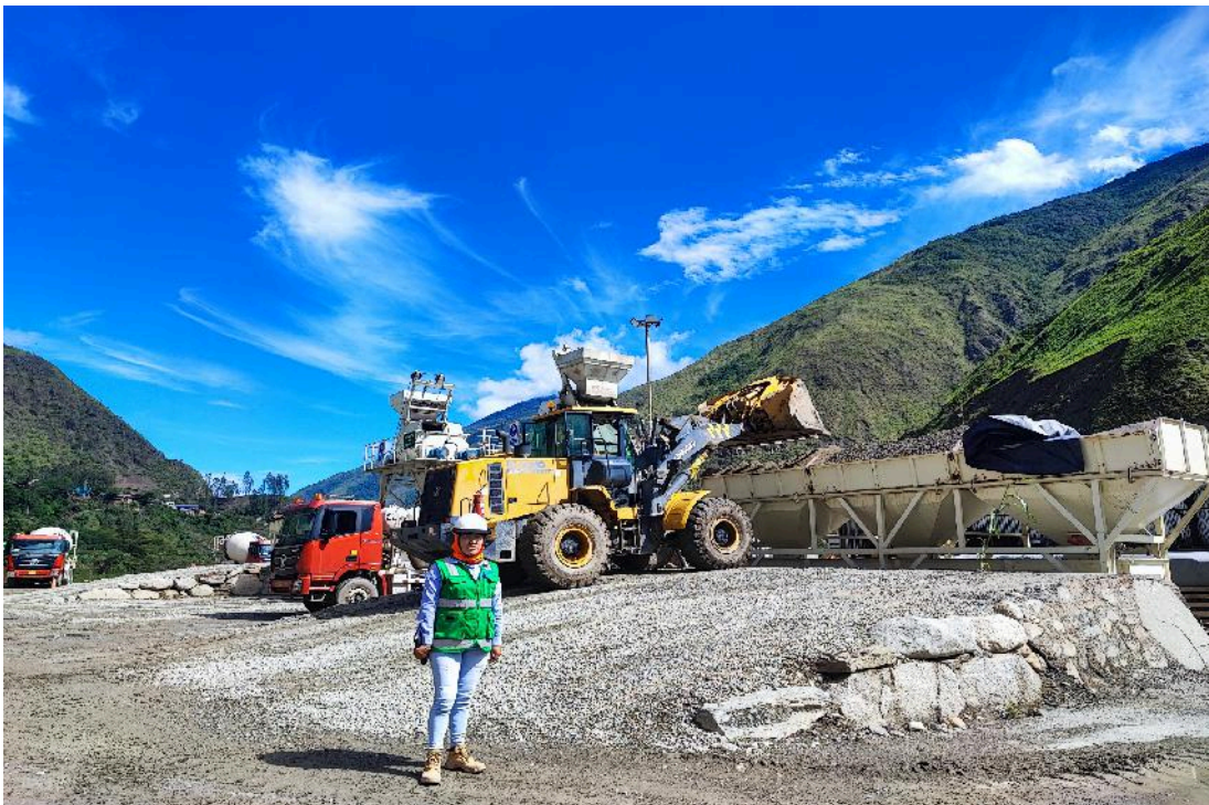
Figura 06: Abastecimiento de agregados a la planta industrial concretera
