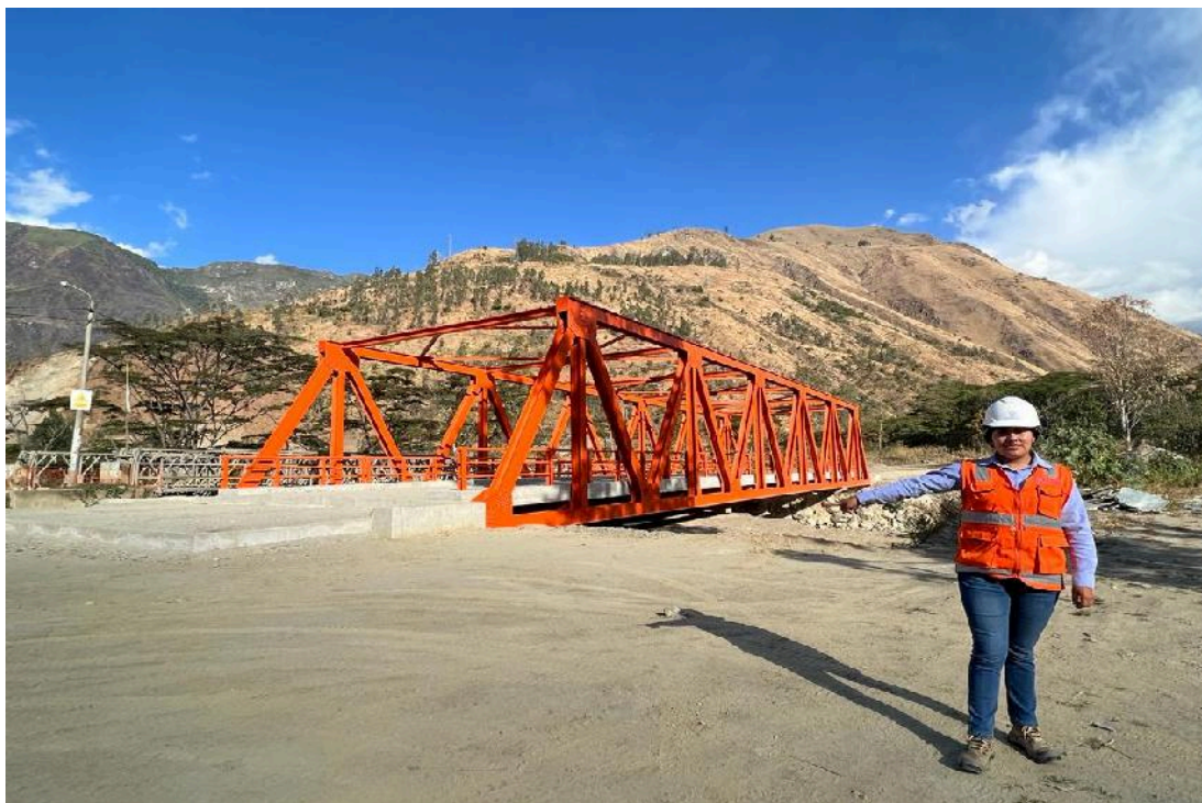
Figura 03: Visualización del Puente Huadquiña construido
