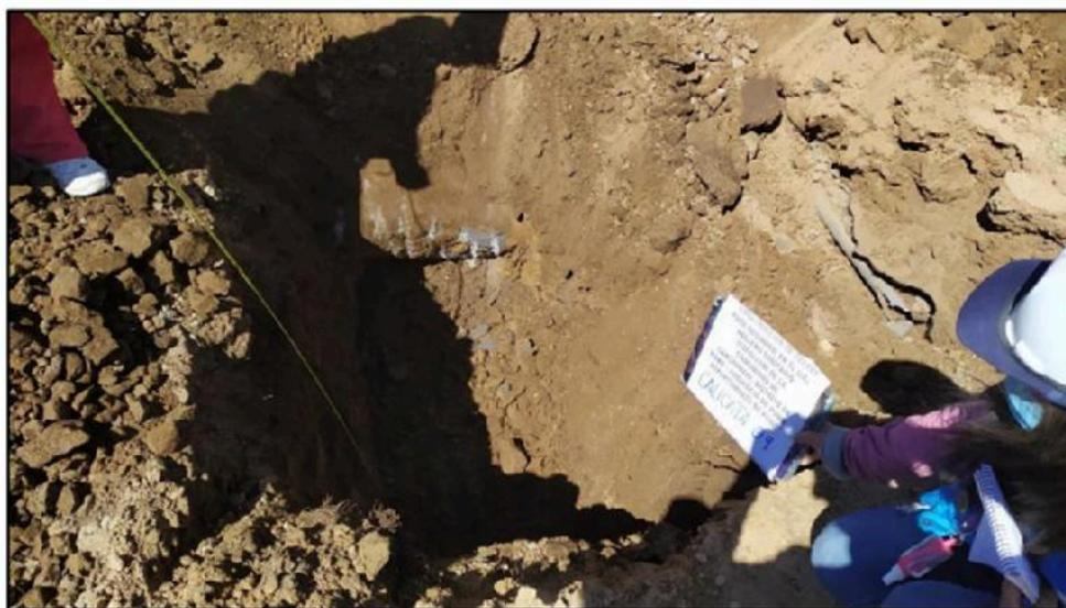
**Figura 44:** Excavación de las calicatas del proyecto el área del estudio de la "Construcción de celdas para residuos; en el relleno sanitario Itapalluni de la comunidad de Cancharani, distrito de Puno.
