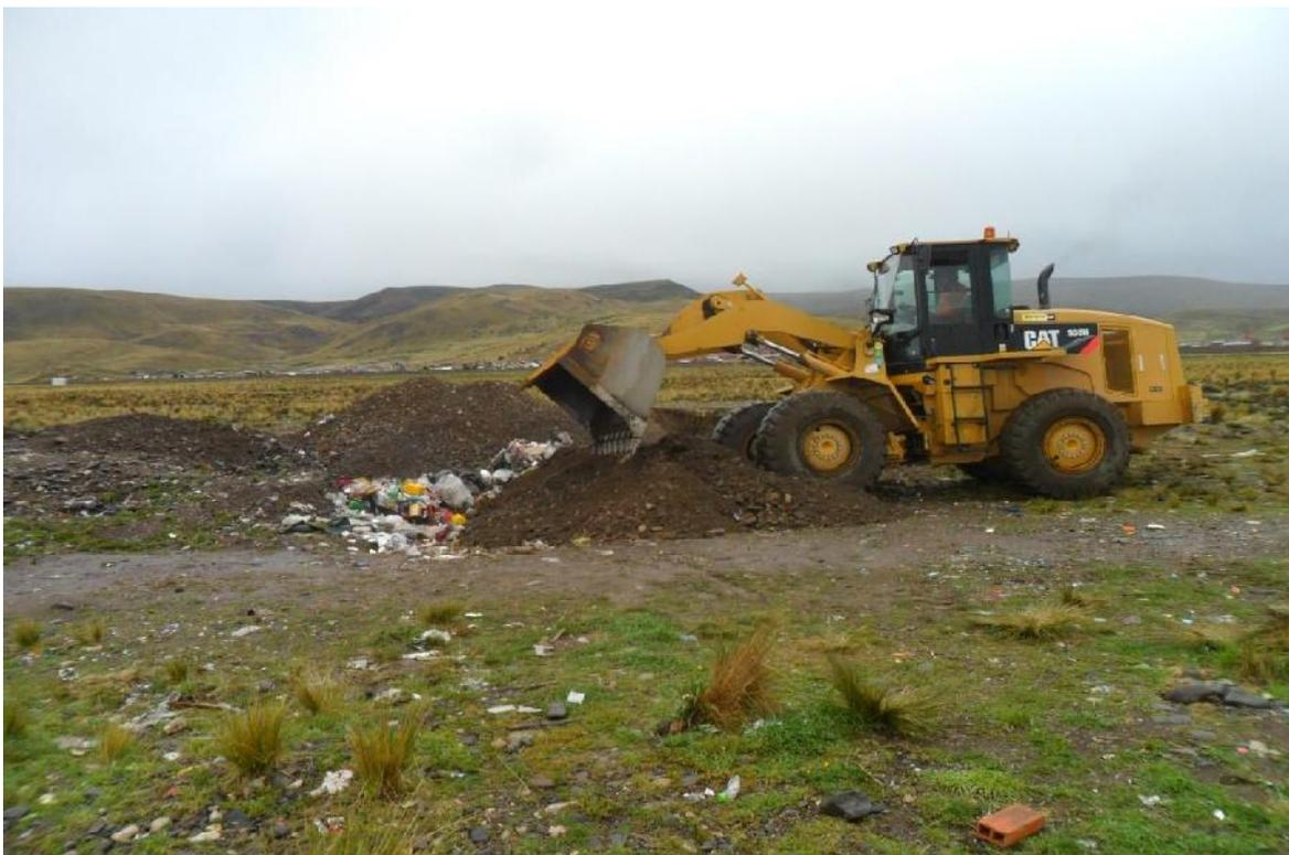
Figura 20. Tapado de la zona de vertido mediante cargador frontal (mensualmente)
