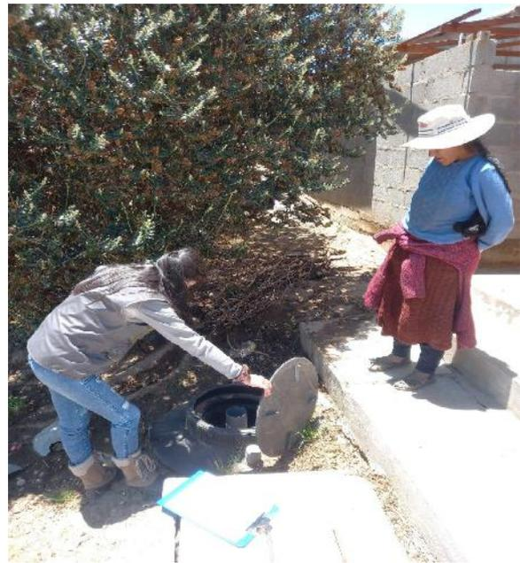
**Figura 07 y 08 :** Verificación del correcto funcionamiento del biodigestor donde se procesan los lodos estabilizados.
