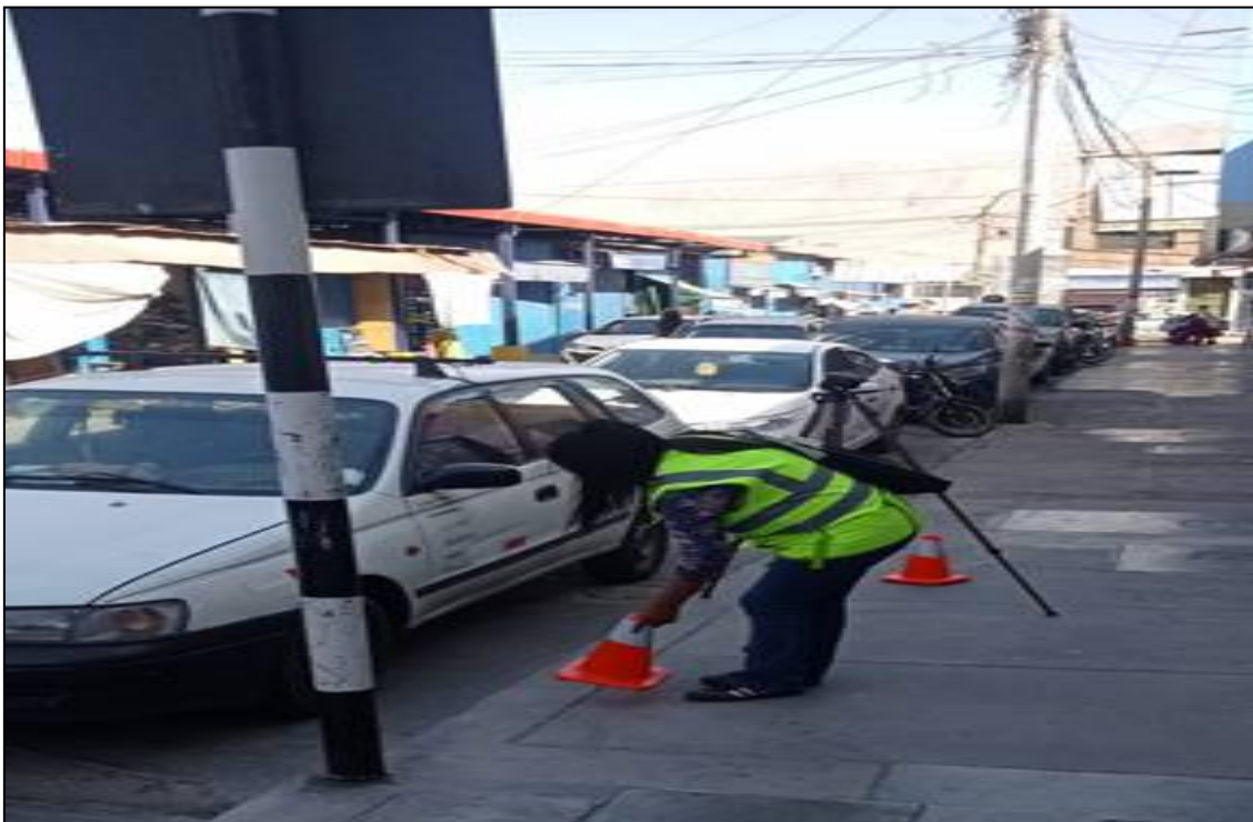
Figura 32: Instalación de conos de seguridad
