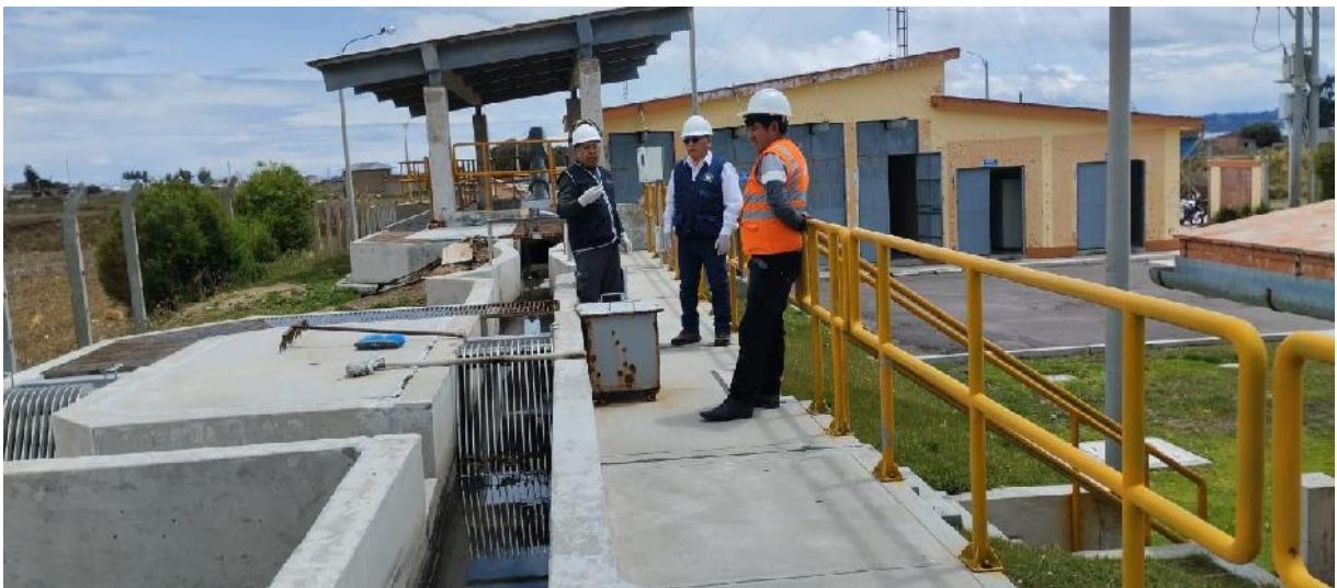
Fotografía 08. Elección del punto de muestreo de la recepción del aguas residuales.
