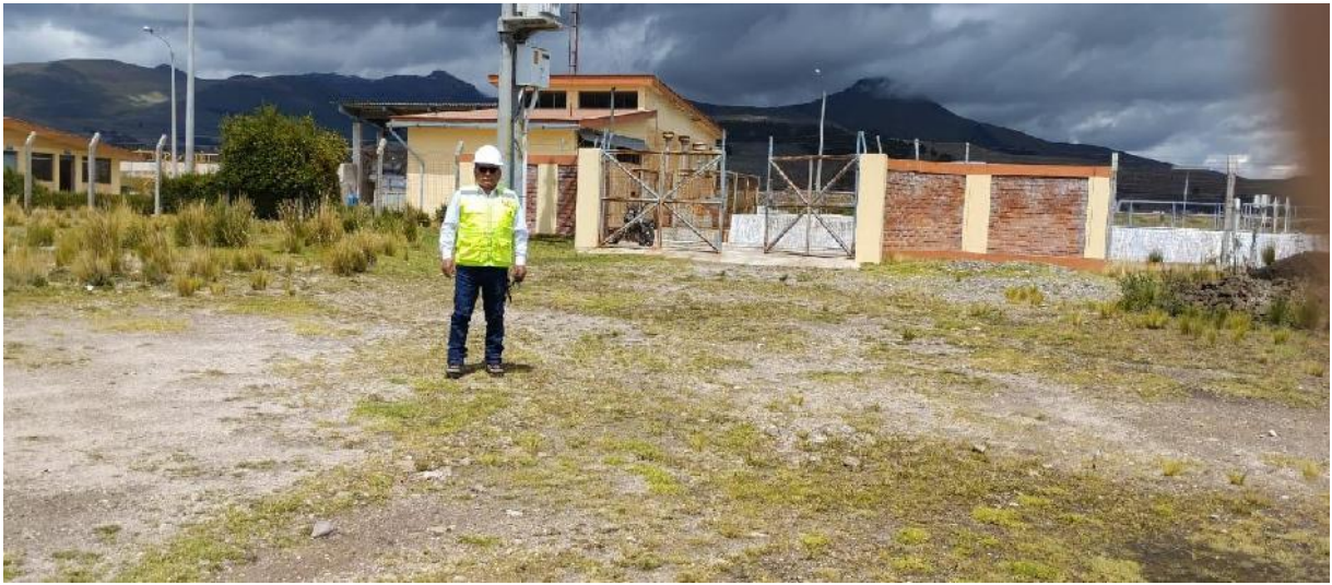
Fotografía 01. Exterior de la PTAR de Yunguyo.
