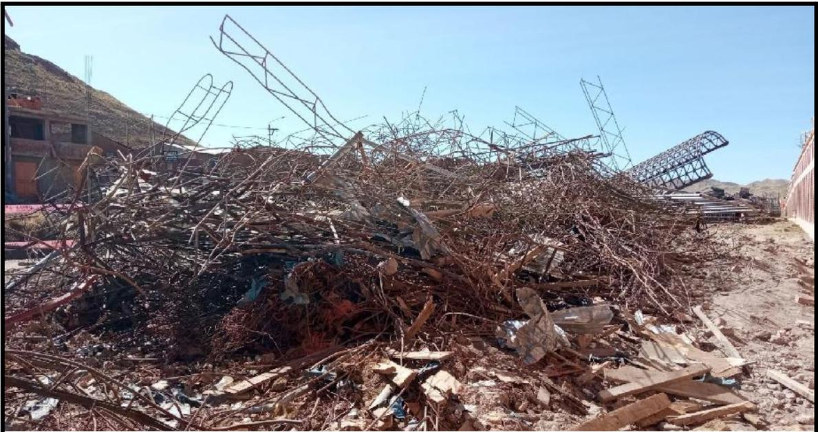
**Figura 04:** Residuos metálicos(residuos industriales) generados al realizar el cambio de infraestructura del colegio.
