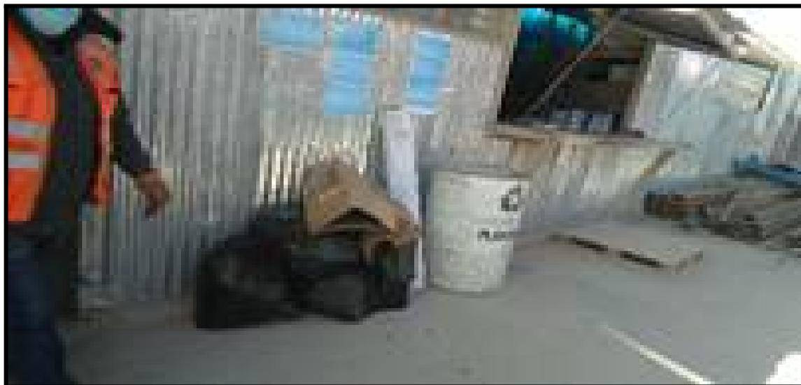
**Figura 08 :** Almacén de la obra (Los residuos generados son juntados y puestos fuera de las instalaciones para luego ser trasladados al punto de acopio temporal).
