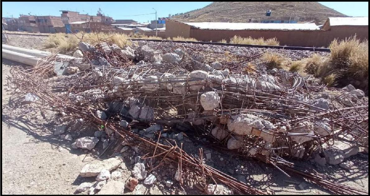
**Figura 03:** Residuos de columnas de concreto y su estructura al hacer el cambio de nueva infraestructura.
