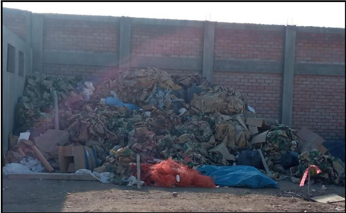
**Figura 07 :** Residuos de bolsas de cemento después de los baseados.(Residuos generados por bolsas de cemento de los vaciados de lozas,tarrajeos sin un lugar específico, tenían una mala clasificación entre los peligrosos y comunes).
