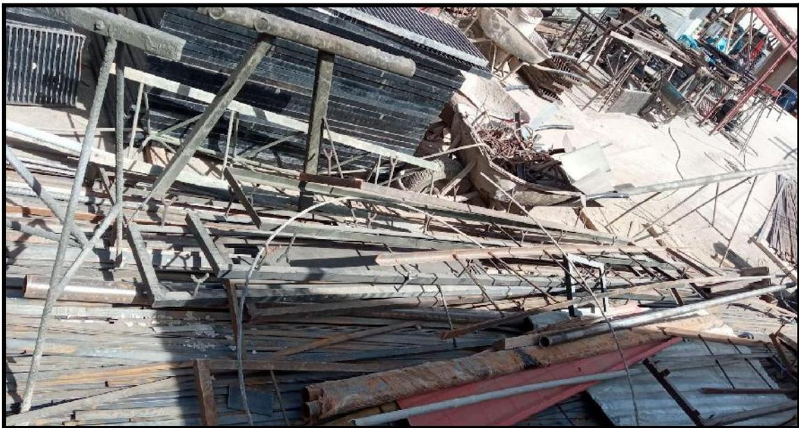
**Figura 14:** Residuos de fierro por el excedente de material y virutas por los trabajos realizados.
