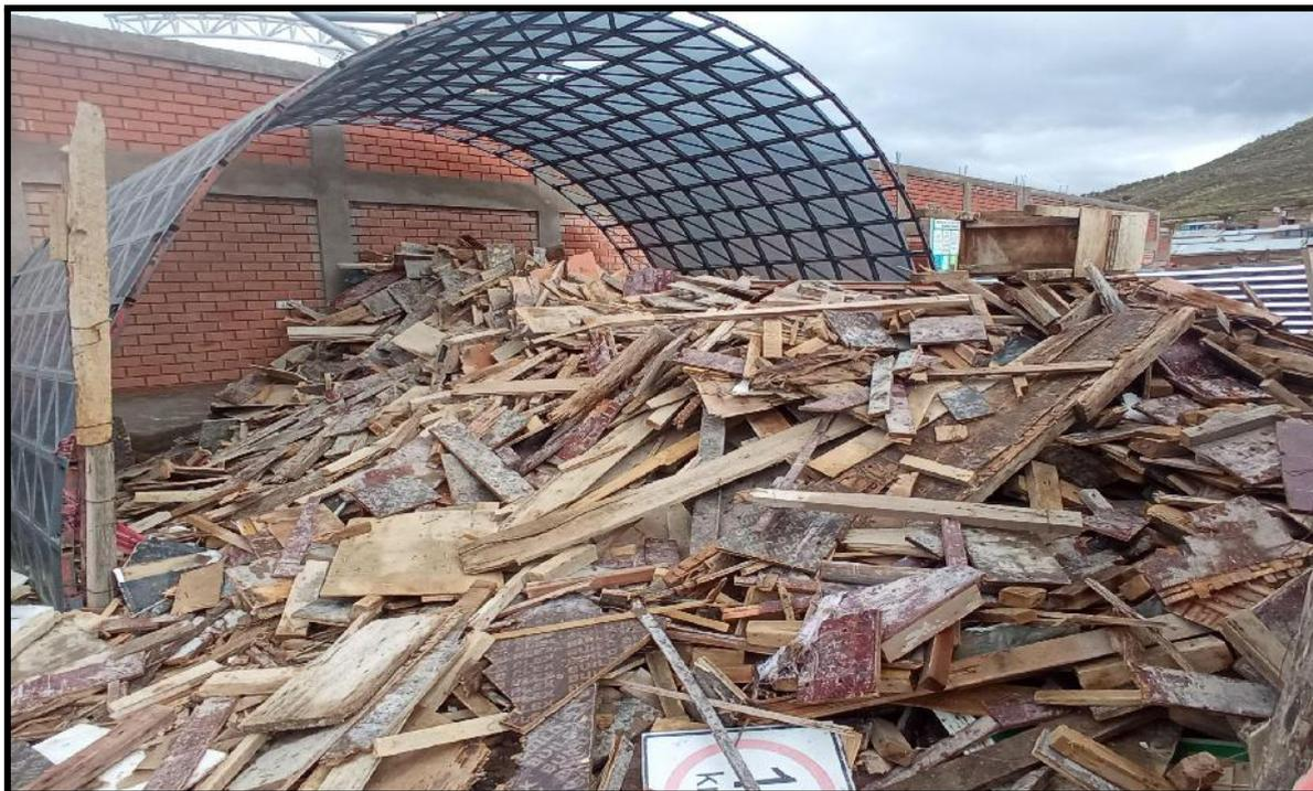
Figura 17: Residuos de madera de los encofrados
