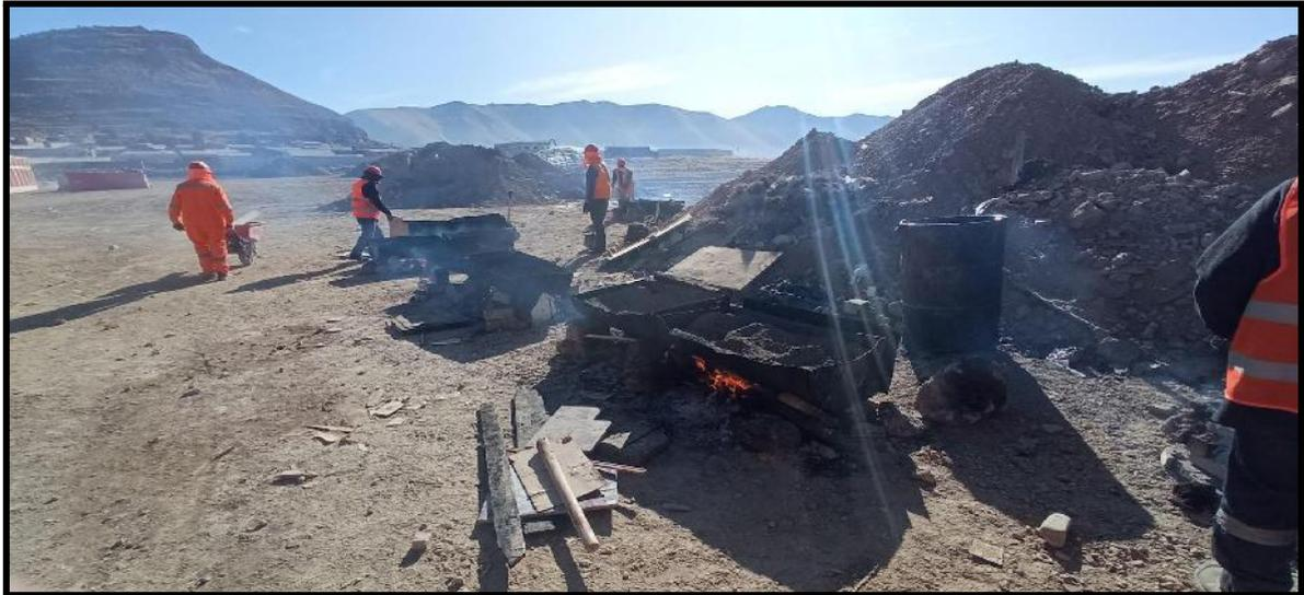
**Figura 07:** Preparación de RC para pista atlética del estadio del colegio y juntas de dilatación, contaminación por el quemado del petróleo crudo.
