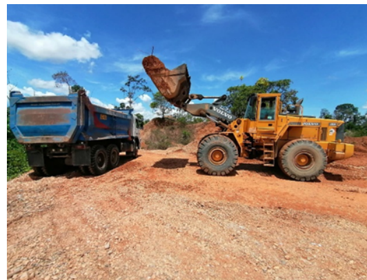
Eliminación de materiales excedentes
