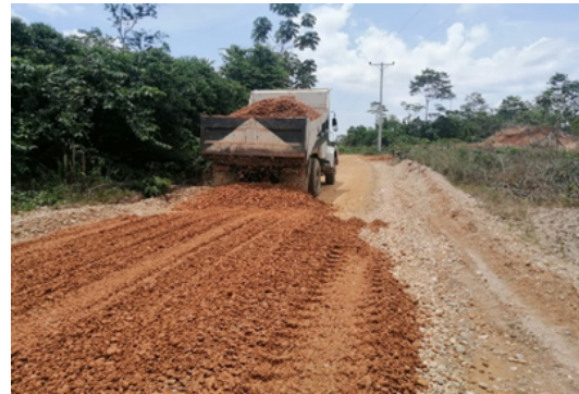
Transporte de material granular
