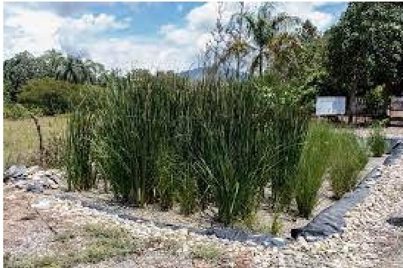
**Figura 50:** Operaciones de siembra de plántulas de totora en un sistema subsuperficial.
