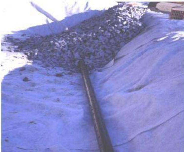
**Figura 47:** Colocación de la tubería de salida en un humedal construido de flujo subsuperficial.
