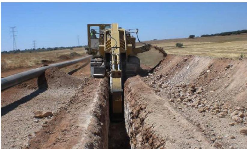
**Figura 46:** Excavación de zanja para la colocación de una tubería.
