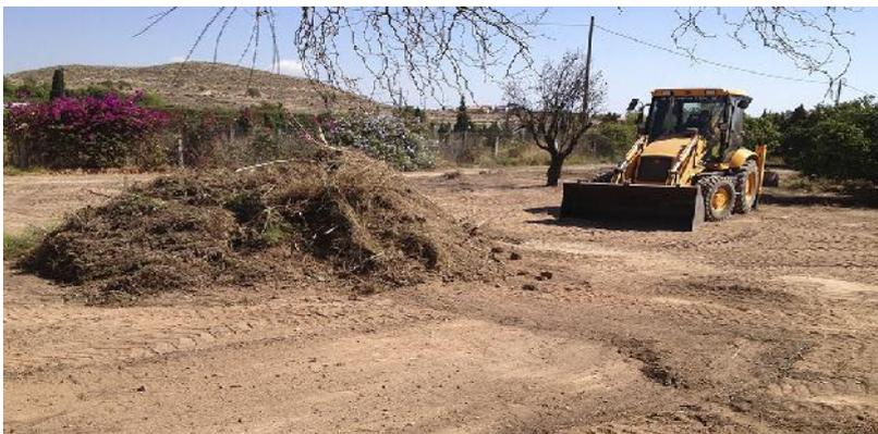
**Figura 45:** Operaciones de limpieza durante la construcción de un humedal construido.
