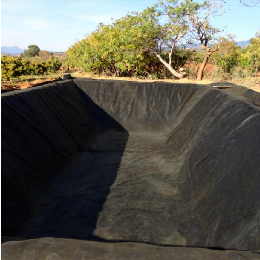
**Figura 48:** Colocación de la geomembrana.
