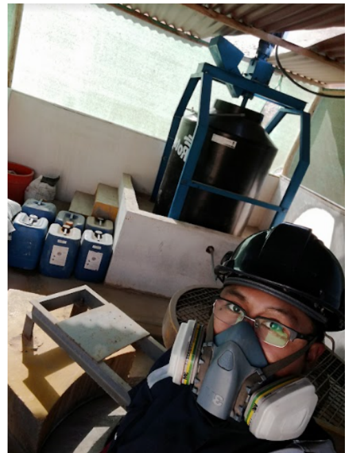
Fig. N° 14 Agitador de Al_2(SO_4)_3 - PTARD
