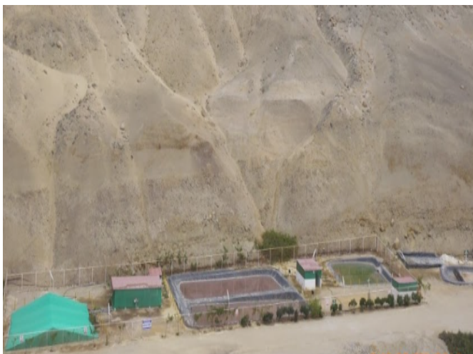
Fig. N° 26 PTARD antes de la optimización
