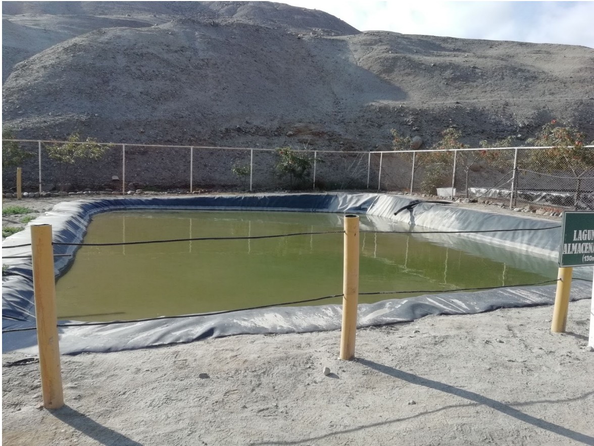
Figura 04. Entrada a la Planta de Tratamiento por una tubería HDPE de 4" de aguas residuales a la laguna de homogenización de caudal.
