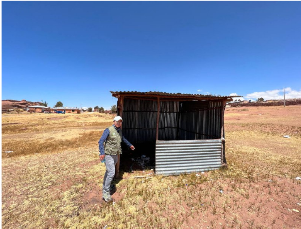
Imagen 05: Se observó pequeñas casetas para el expendio de productos que están abandonados.
