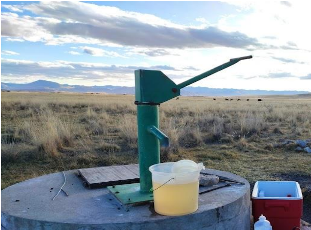
Figura 27: Pozos Caisson con sistema manual.
