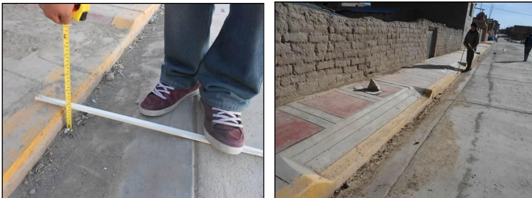
Figura 06: Fotografía donde se aprecia la verificación de las alturas de la vereda según planos del expediente técnico
